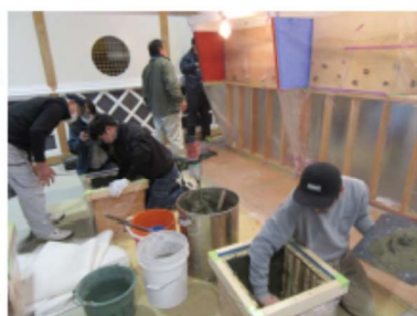
手前は炉壇巻竹取付け、荒壁付
